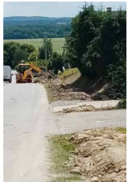
Zamjena plinskih cijevi u Livadarskoj I. Gusić
