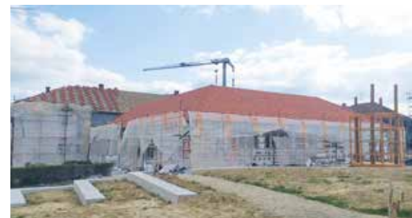
Čazmanska osnovna škola u obnovi
