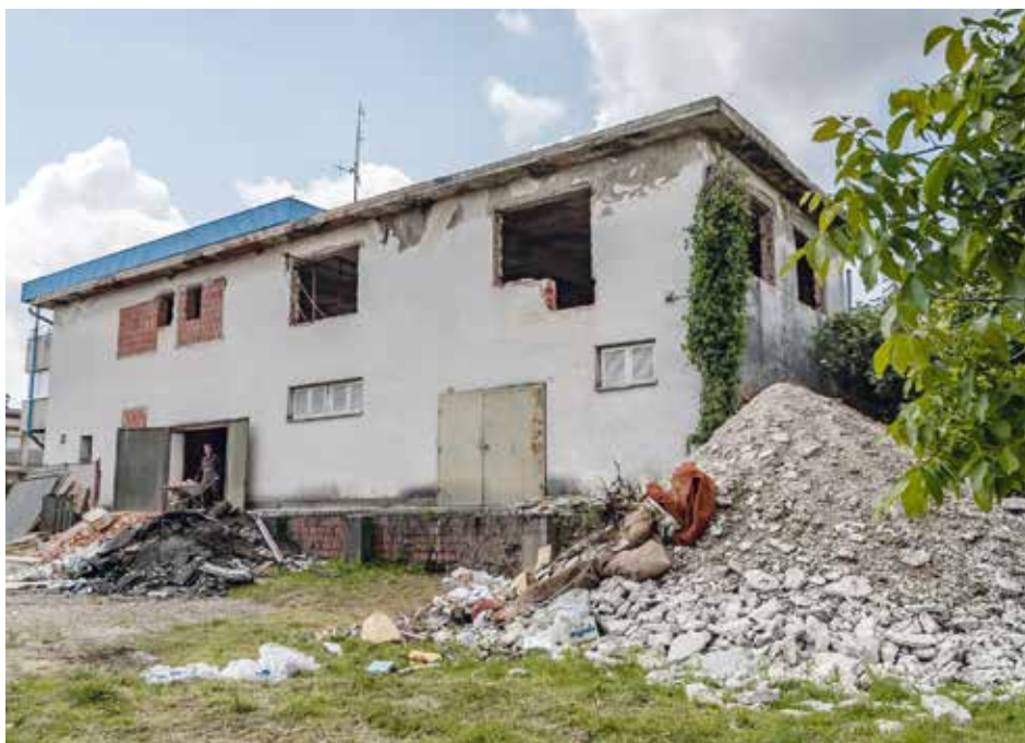
PZgrada nekadašnje Teritorijalne obrane obnavlja se kako bi omogućila smještaj udrugama
