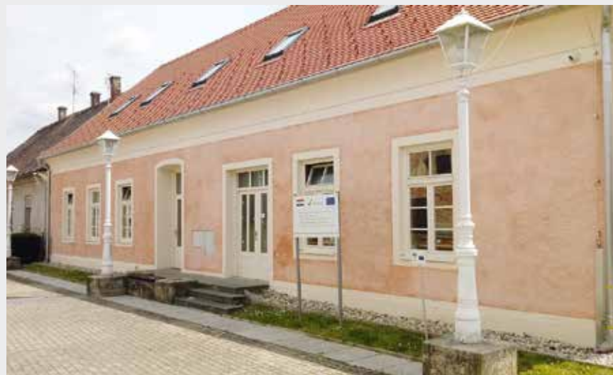
Počelo je uređenje unutrašnjosti zgrade budućeg multifunkcionalnog centra na trgu u Čazmi
